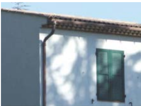
Gouttière et descente EP en cuivre
