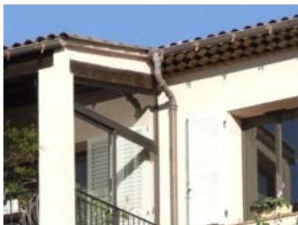
Gouttière et descente EP en cuivre
