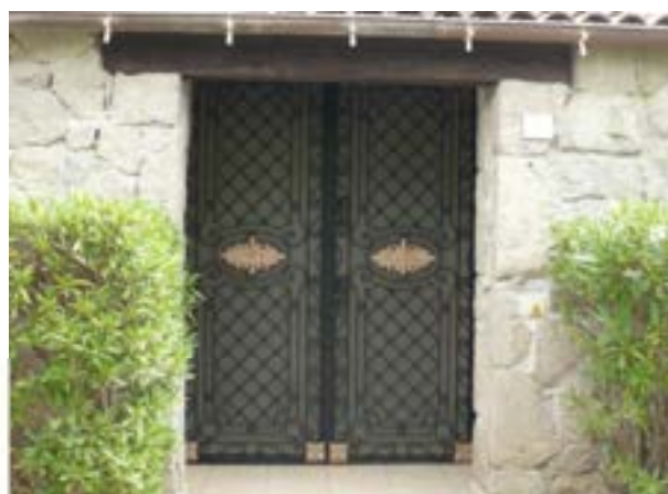
le problème, est que ce modèle de ferronnerie trop chargée, est installé le long de la même voie...
